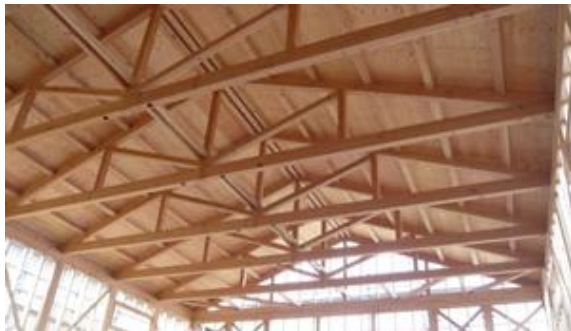
流通製材と住宅用プレカットによる 12mスパン山形トラス
