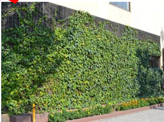
公共施設壁面緑化施工例
