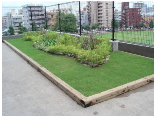
屋上緑化施工例
