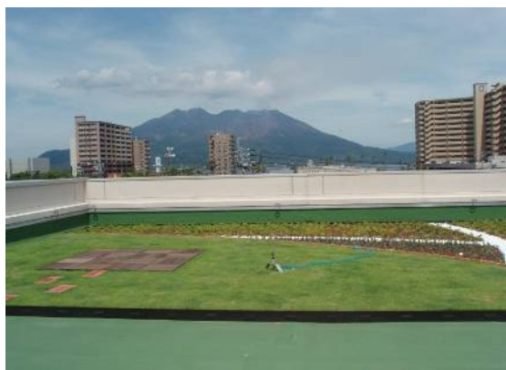
屋上緑化施工例
