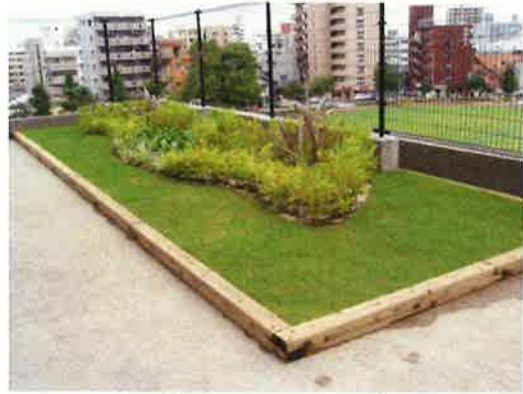
屋上緑化施工例
