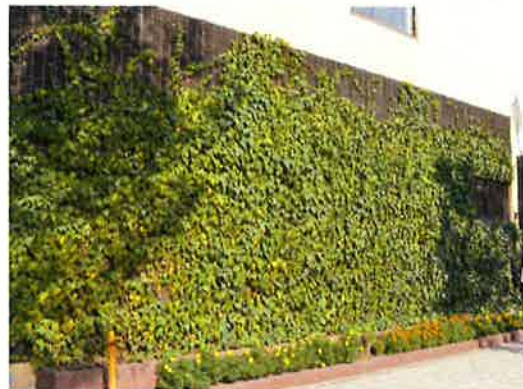
公共施設壁面緑化施工例
