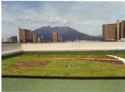
屋上緑化施工例
